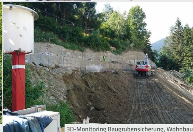
3D-Monitoring Baugrubensicherung, Wohnbau
