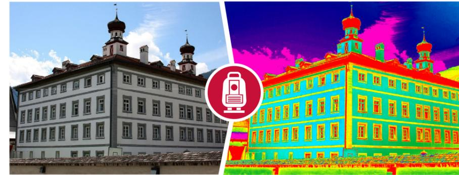
Der 3D-Laserscanner liefert eine 3D-Punktwolke aus der das 3D-BIM Modell abgeleitet wird, das im Datenformat der Software des Architekten übergeben wird.
